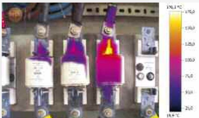
Con TwinPix se ve sin tocarlo cual es el diferencial que podría fallar
